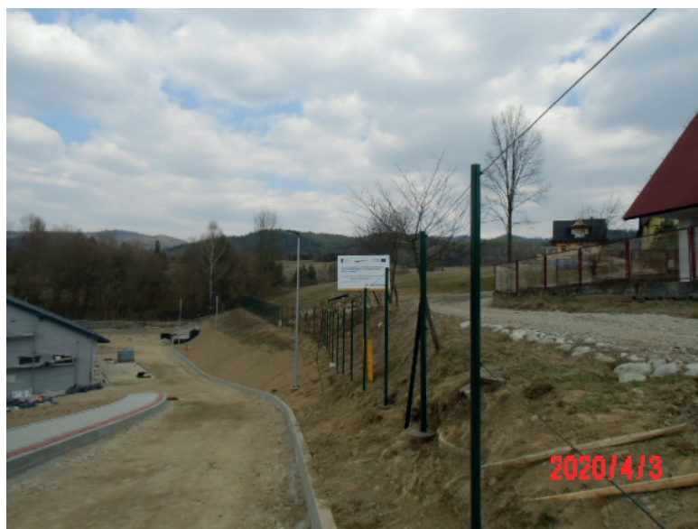
W ramach realizowanego projektu wykonana została m.in. droga dojazdowa do punktu odioru odpadów
